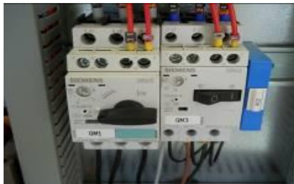
Abbildung 15 – Pumpenschalter auf ON
