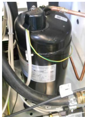
Abbildung 21 – Position des Kompressors
