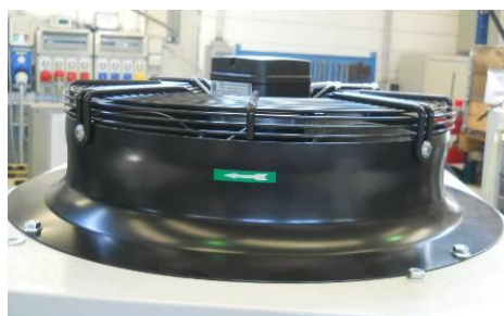
Abbildung 20 – Drehrichtung des Lüfters (Beispiel)
