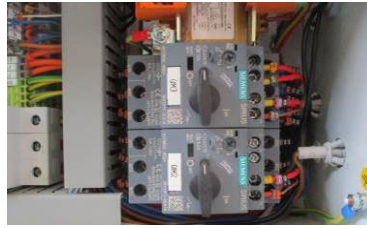
Abbildung 12 – Pumpenschalter auf ON
