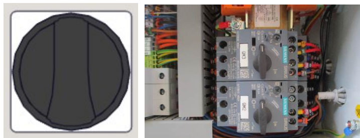
Abbildung 7 – Hauptschalter OFF Abbildung 8– Trennschalter OFF
