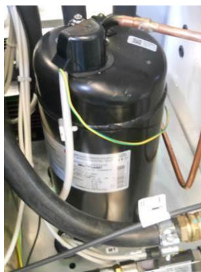
Figura 21 – Posición del compresor
