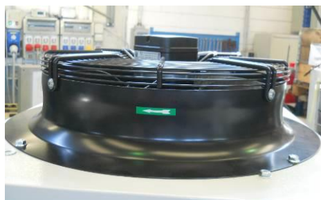
Figure 20 – Exemple de sens de rotation du ventilateur
