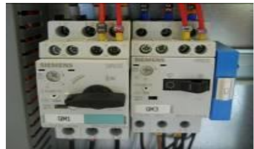
Рисунок 8 – Автоматические выключатели выключены
