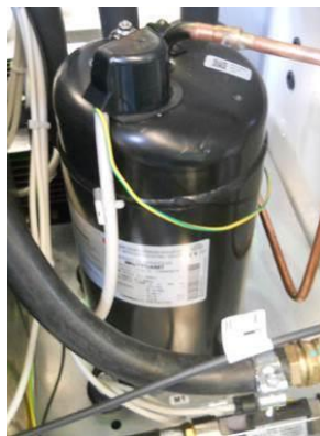
Abbildung 21 – Position des Kompressors
