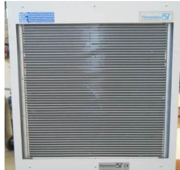
Figura 24 – Superficie exterior del condensador
