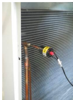
Реле высокого давления
