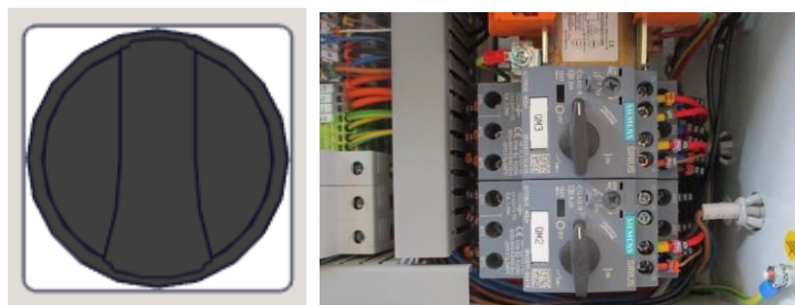
Рис. 7 – Гл.выкл. ВЫКЛ. Рис. 8 – Выкл.контура ВЫКЛ.
